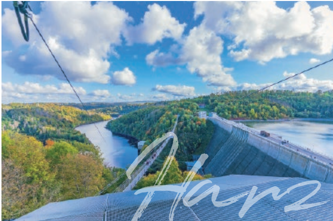
Die Hängebrücke Titan RT ist weltweit die längste Stahlseilbrücke ihrer Art.
