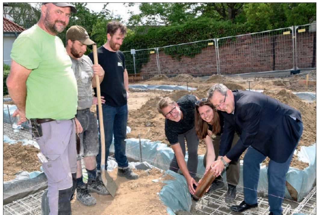
Matthias Kaufmann, Carolin Bettels und René Marienfeldt (von rechts) beim Einlegen der kupfernen Dokumentenhülle in den Beton des Fundamentes. Text und Fotos: Hans-Theo Wiechens
