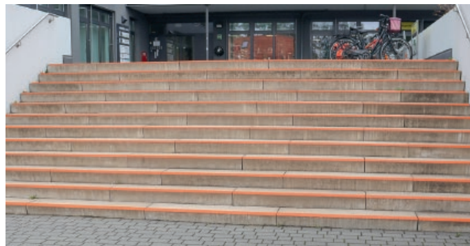
Die kontrastreich markierten Stufenkanten am Außeneingang des Dornberg Carrées.
